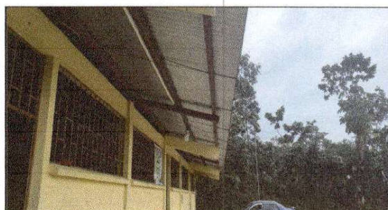
FOTO 6: Sustrucción de canal de metal, Sustrucción de bajada de agua pluvial de metal por tubo PVC 3" y Sustrucción de soporte o pescante de metal para canal.
