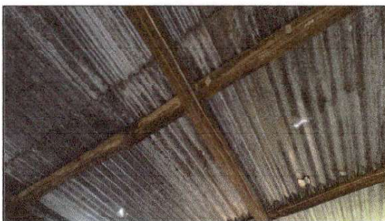
FOTO 9: Sustitución de lámina, por lámina troquelada aluzinc calibre 26 Y Sustitución de estructura de soporte de madera, por metal
