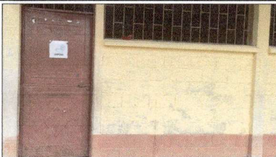
FOTO 7: Fabricación e instalación de puertas de metal en módulos
