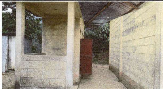
FOTO 1: Sustrucción de lámina, por lámina troquelada aluzinc calibre 26 Y Sustrucción de estructura de soporte de madera, por metal
