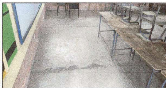
FOTO 5: Sustrucción de piso cerámico
