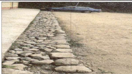
FOTO 8: Reparación de banquetas de concreto
