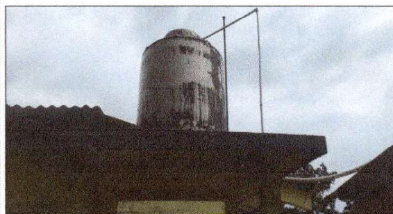
FOTO 3: nc calibre 26 Y Sustrucción de estructura de soporte de madera, por metal
